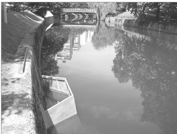
Slika 5: Zaščitni element za preprečevanje zastajanja plavja (foto: Matej Sečnik)
